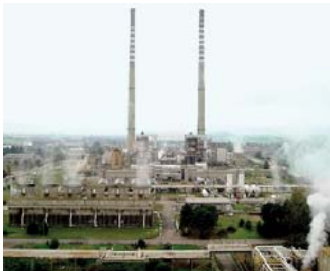
La centrale elettrica di Ottana
